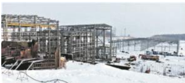
НА СТРОЙПЛОЩАДКЕ ООО «ДАЛЬГРАФИТ»
